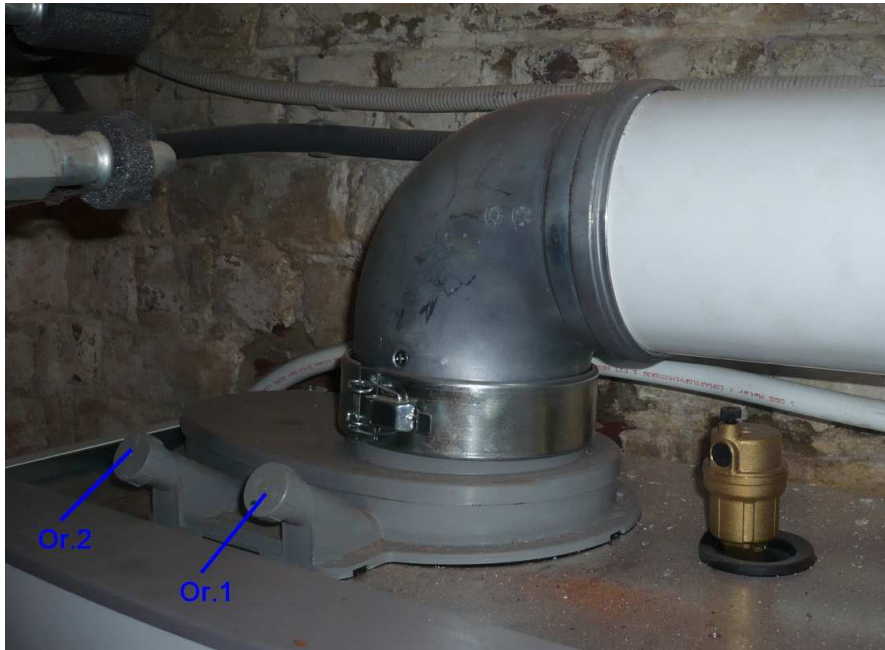
Figuur 4.2: Montage van meetopeningen
