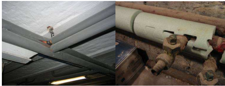
Figuur 10.6: warmte-isolatie van verwarmingsleidingen
