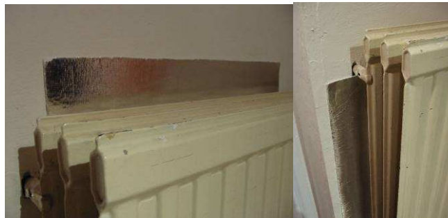
Figuur 10.7: reflecterend scherm achter een radiator
